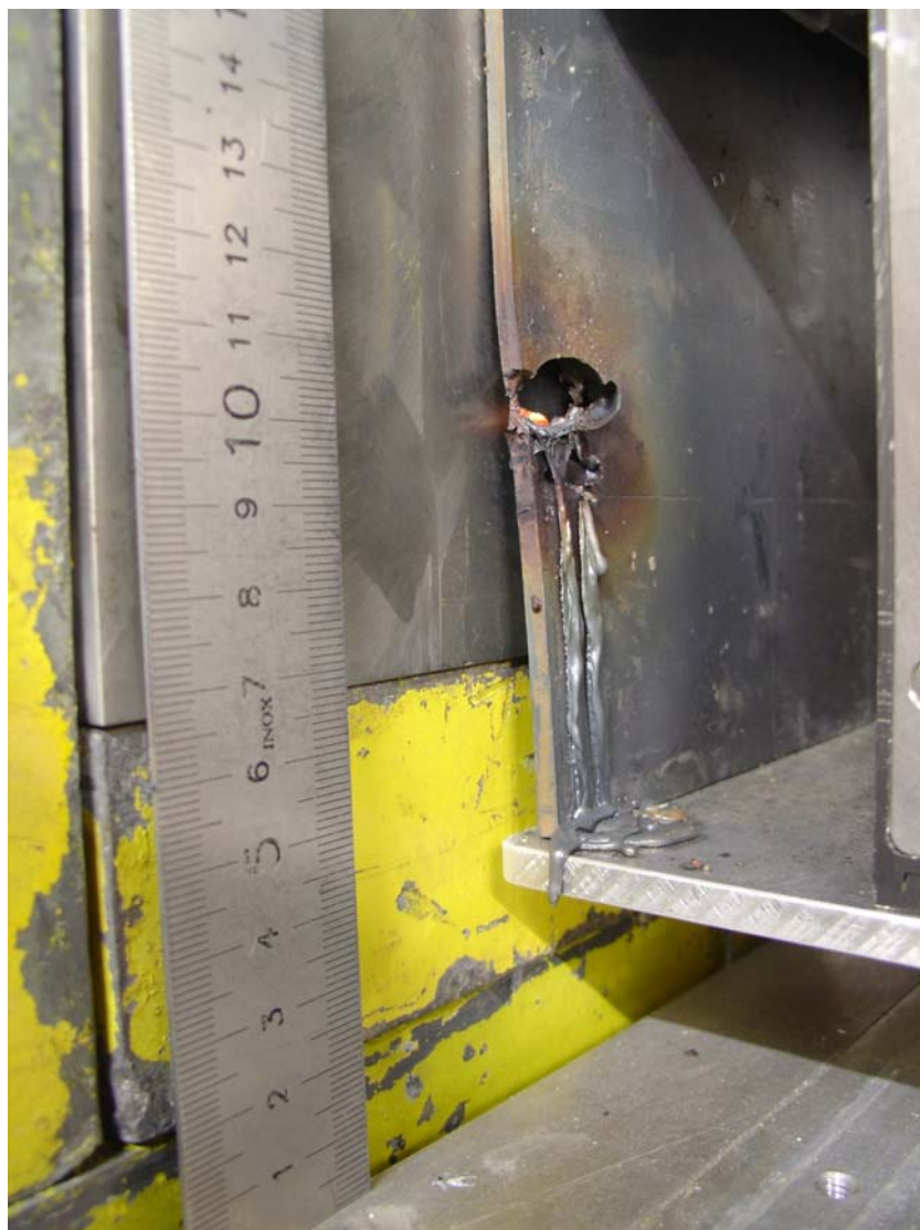
FIG. 3.24 – Trou sur une plaque de plomb, située devant les calorimètres, causé par des radiations synchrotron.
