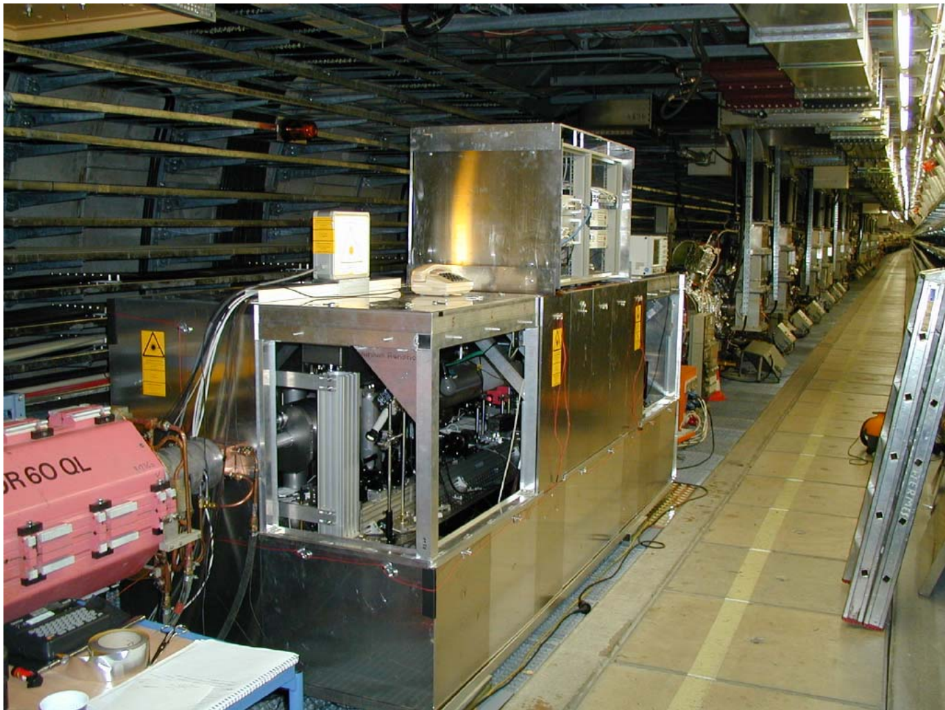
FIG. 2.12 – Image de la cahute en plomb de la cavité. Les éléments électroniques sont situés en haut de la cahute en plomb.
